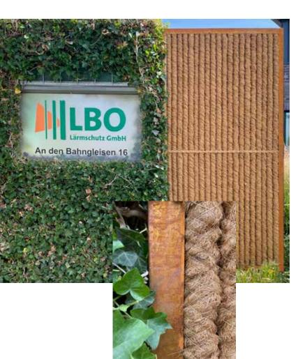
Cortenstahl ist eine spezielle, besonders unempfindliche und wetterfeste Stahlart. Auf dem Rahmen bildet sich nach einiger Zeit selbstständig die Edelrost-Patina. Durch die Patinabildung wird ein durchrosten verhindert.
