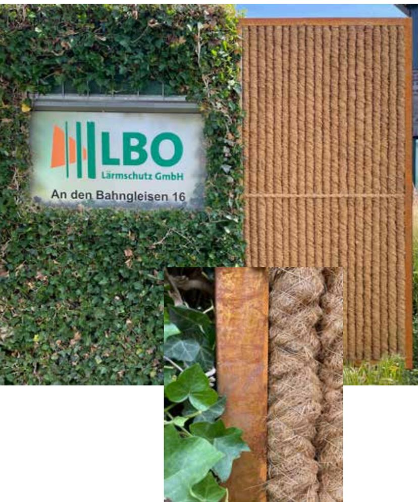
Cortenstahl ist eine spezielle, besonders unempfindliche und wetterfeste Stahlart. Auf dem Rahmen bildet sich nach einiger Zeit selbstständig die Edelrost-Patina. Durch die Patina-Bildung wird ein durchrostern verhindert.
